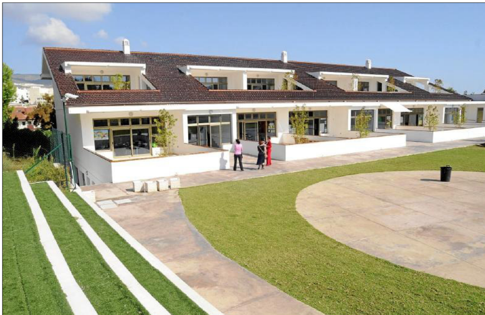
Edificio de aulas de Primaria con el espacio de recreo y ágora en primer plano del Colegio Internacional Torrequebrada. / REPORTAJE GRÁFICO: NACHO ALCALÁ
